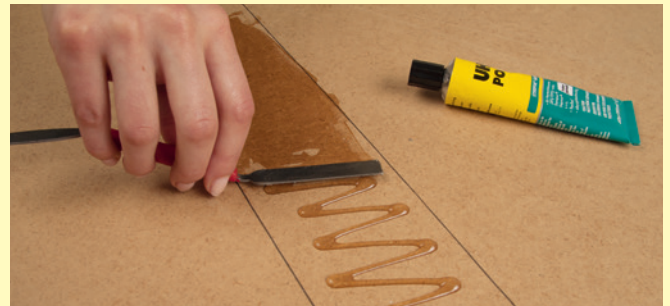
Auf den Untergrund wird mit einem Spachtel Klebstoff aufgetragen. Wir empfehlen die Verwendung von UHU® POR.
