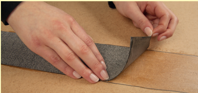
Die Struktur-Straße wird in das Klebebett eingedrückt und dem Untergrund angepasst.
