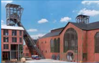
Maschinenhalle und Förderturm
